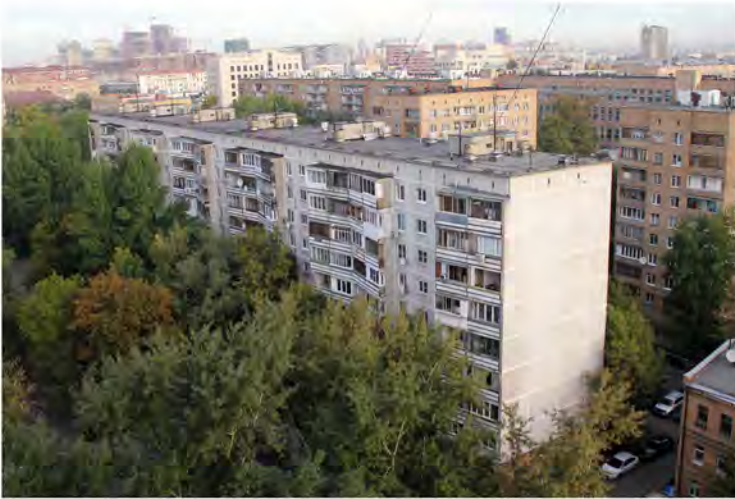
ПАНЕЛЬНЫЙ ЖИЛОЙ ДОМ СЕРИИ 1-515/9Ш
